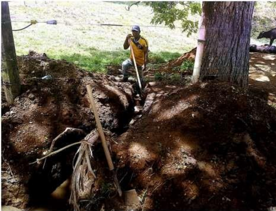
Fuente Propia, foto tomada en el lugar de la obra, en compañía de los funcionarios de planeación municipal. Amputación de raíces a ejemplar arbóreo Samanea samán.
