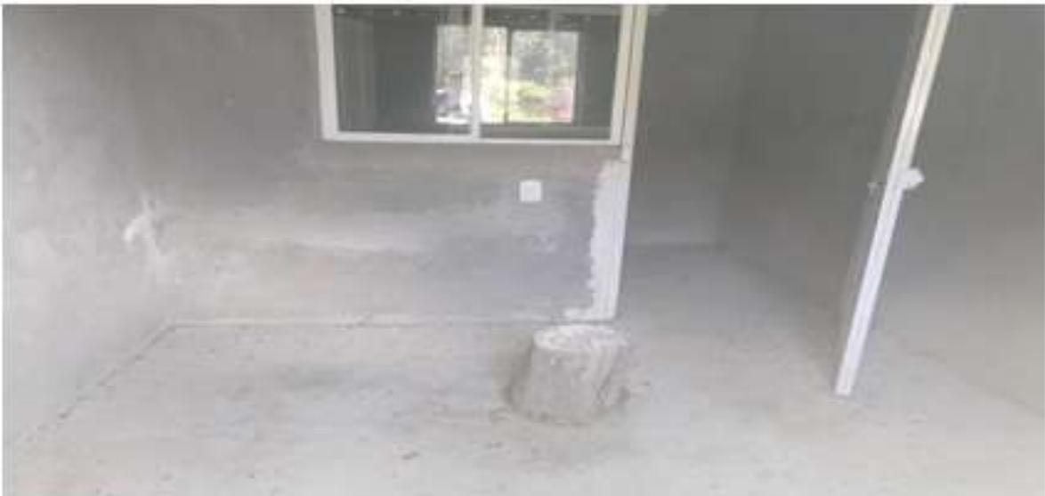
Foto 3. Circasia. Construcción de ampliación al coso municipal, interior de la construcción en obra gris.
